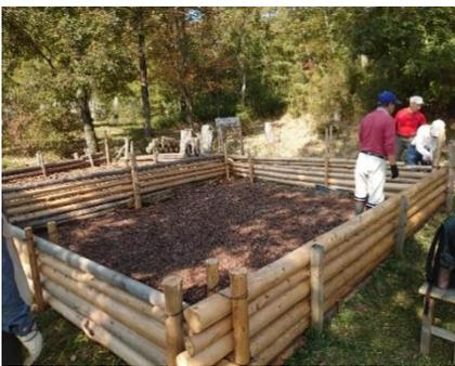
線を切って、傷んだ枠や丸太を取り除き、使えるものと使えないものにと仕分けした。以前に、杉林から運び出し「カブトムシの森」においてあった新しい丸太を下の方に置き、まだ見えそうな古い丸太は、次回に取り換えやすいように、一番上にのせるようにした。杭を打ち、丁寧に丸太の長さをそろえてのせていった。杭と杭を番線でしっかりと縛って丸太を固定し、頑丈な枠に仕上がった。このなかの完熟腐葉土は花のテラスの花壇に入れて空にし、落ち葉掻きのイベントに備える予定である。活動終了時間より
